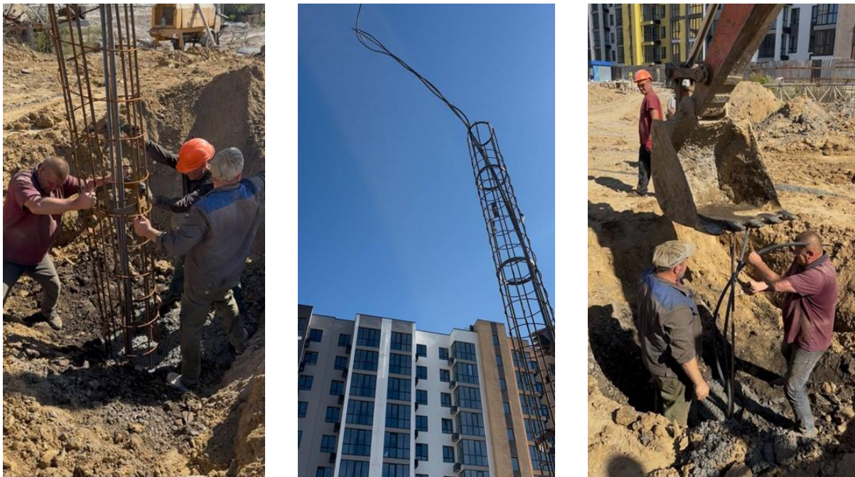
Рисунок 1 – Експеримент по влаштуванню U-подібного теплообмінника в буроін'єкційну палю
