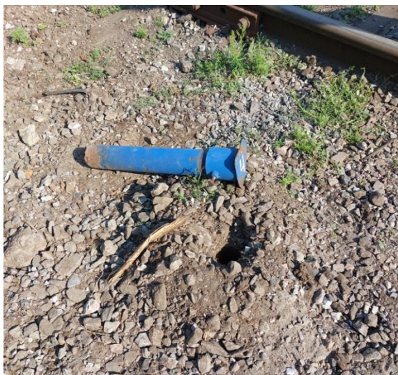
Рисунок 1 – Фото пошкодженої режимної свердловини на території ТОВ «ДООЗ» в м. Дніпро [6]
