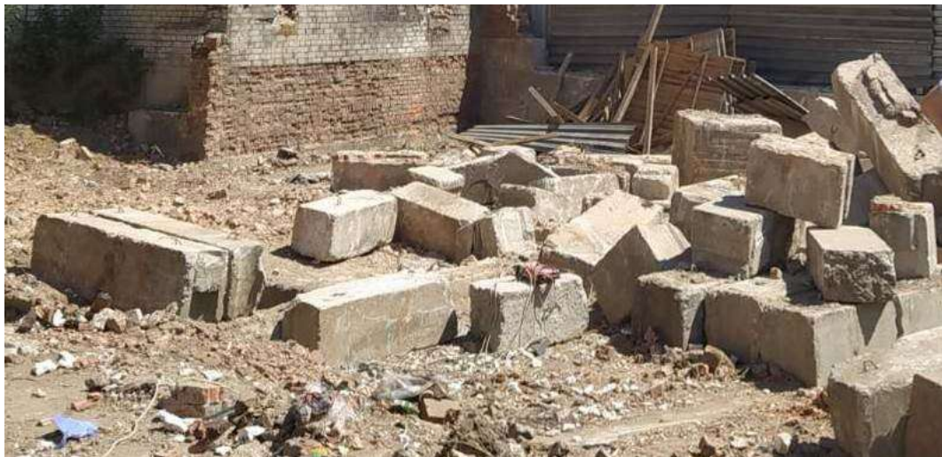
Рисунок 1.5. Демонтовані конструкції пального фундаменту в місці нової забудови, вул. 93-ї Холодноярської бригади, м. Дніпро
