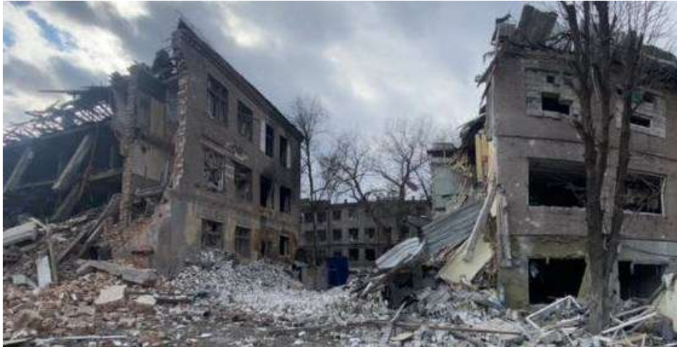
Рисунок 1.2. Зруйнована внаслідок ракетного обстрілу сходові клітина взуттєвої фабрики в м. Дніпро
