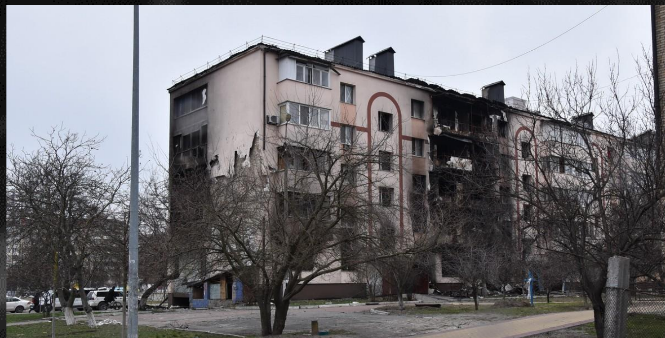
Рис. 11 – Вид будівлі з внутрішнього двору
