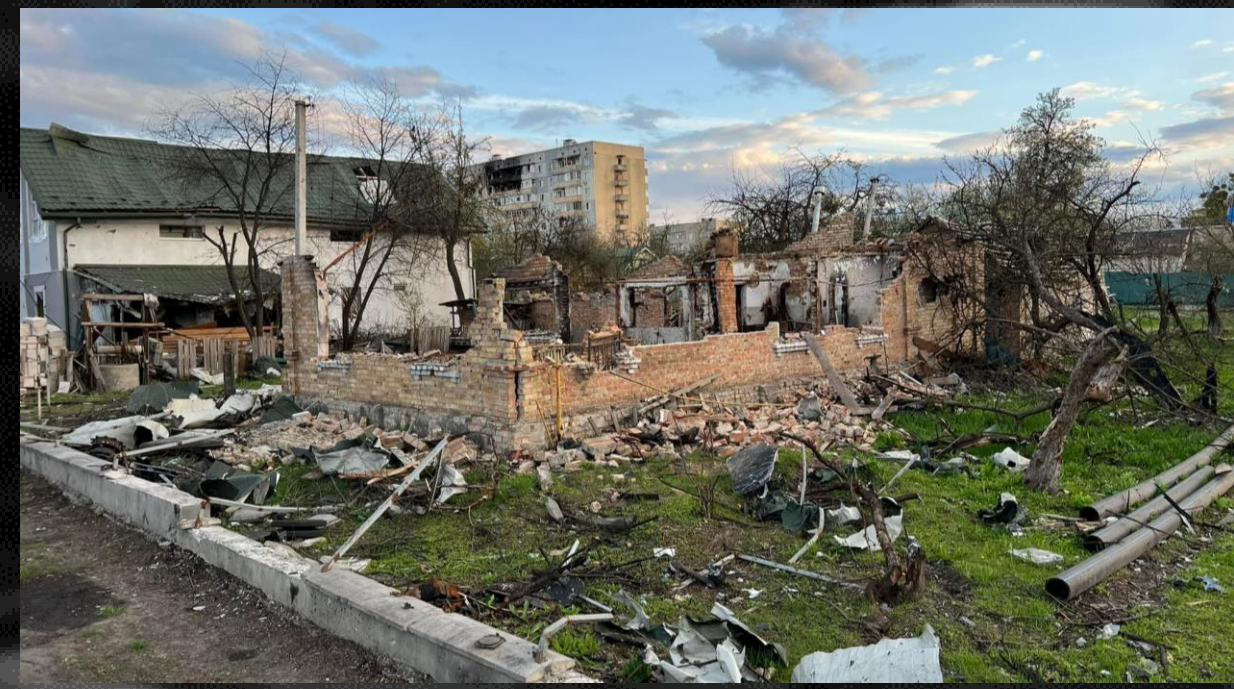
Рис. 23 – Повністю зруйнований приватний будинок
