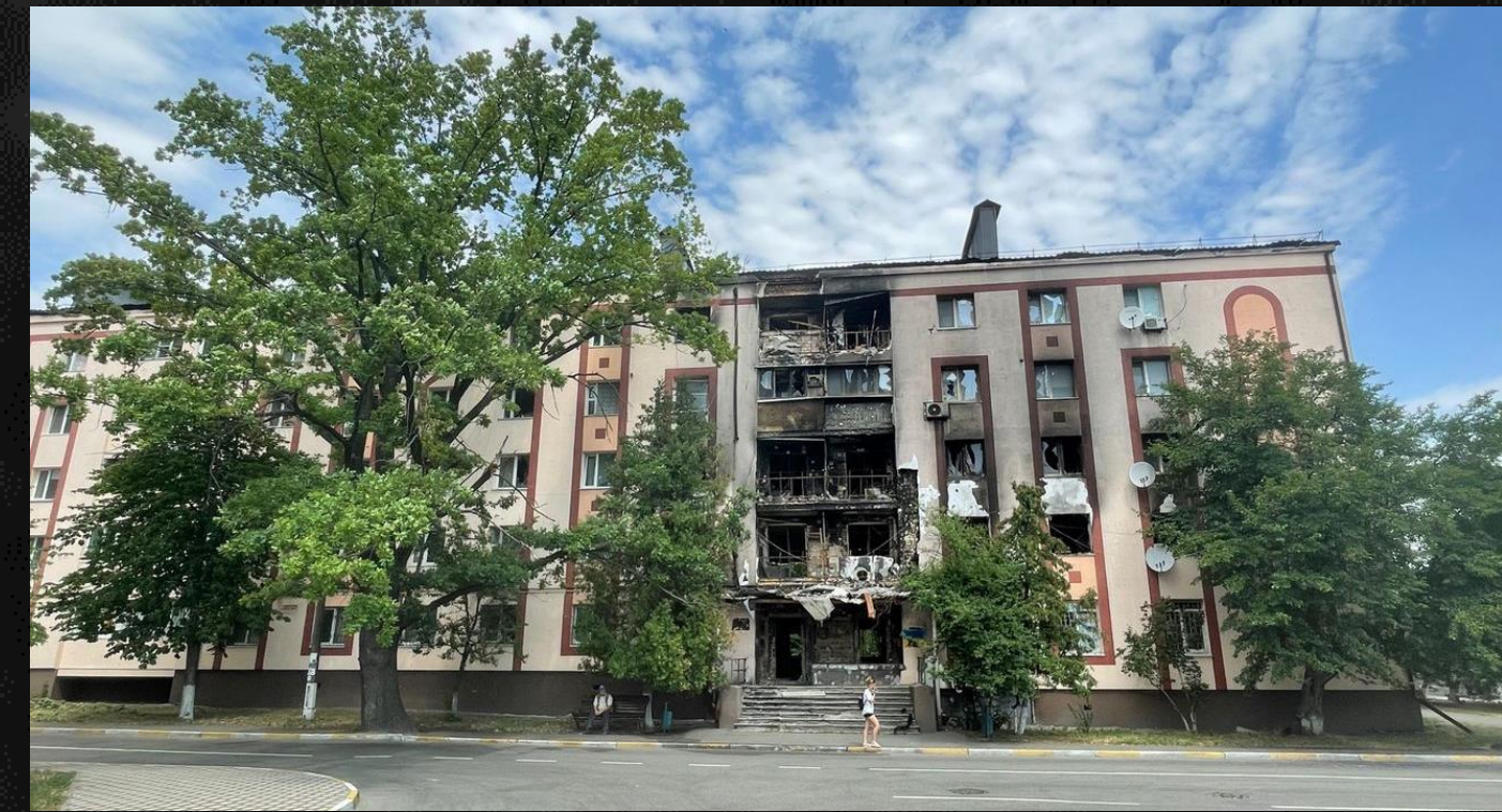
Рис. 10 – Зруйнований фасад будівлі
