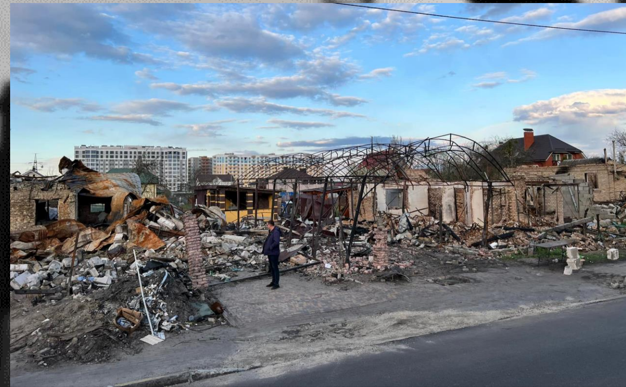
Рис. 21 – Повністю зруйновані будинки вздовж вулиці
