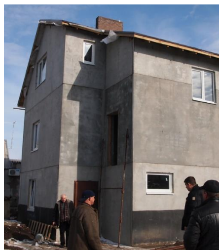
Рис. 2. Будівництво котеджу з тришарових панелей у м. Дніпро
