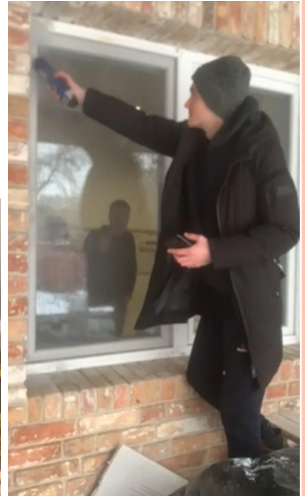
Підготовка приміщення до експерименту з герметизації будівлі
