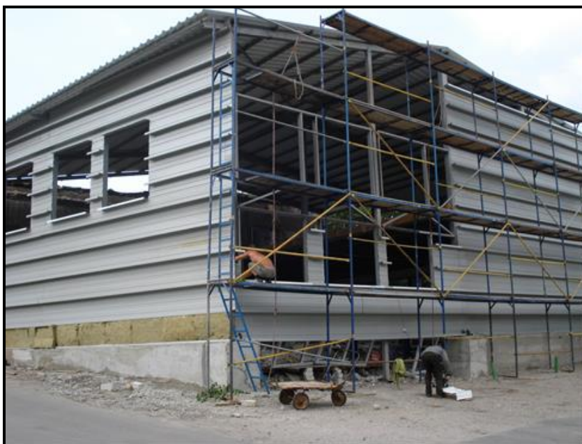
Рисунок 5.10 – Застосування стінової загороди виробничої будівлі з використанням самонесучих стінових касет
