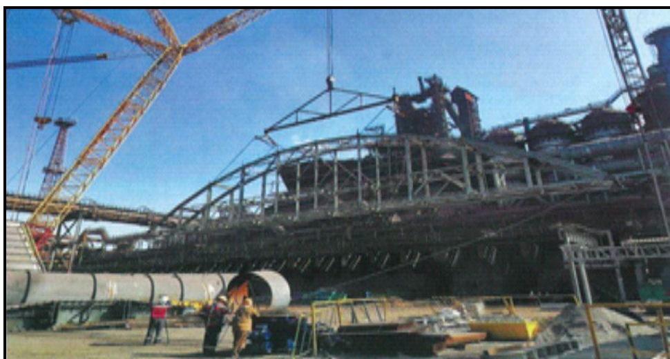
Рисунок 5.11 – Система аспірації ливарного двору, а також бункерна естакада доменної печі № 3 на ПАТ МК «Азовсталь»
