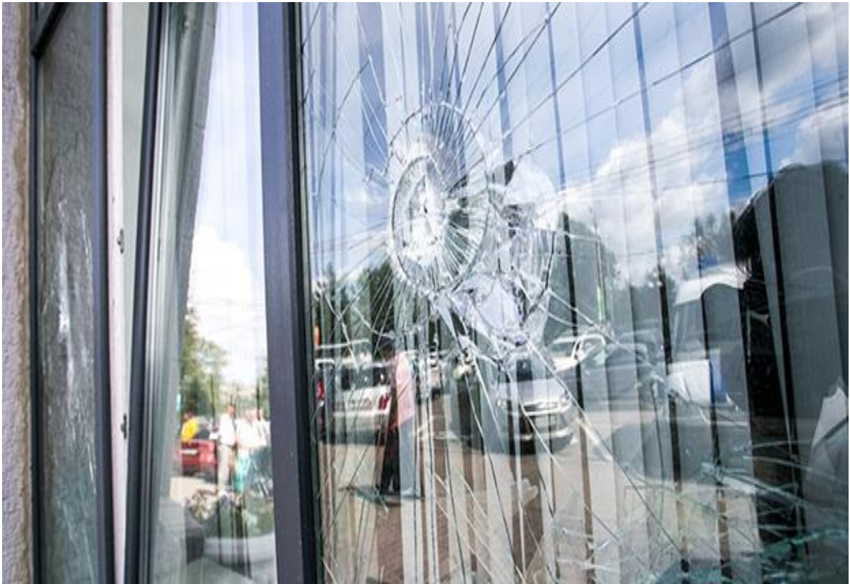
Рисунок 1.12 – Механічне пошкодження фасадного остеклення
