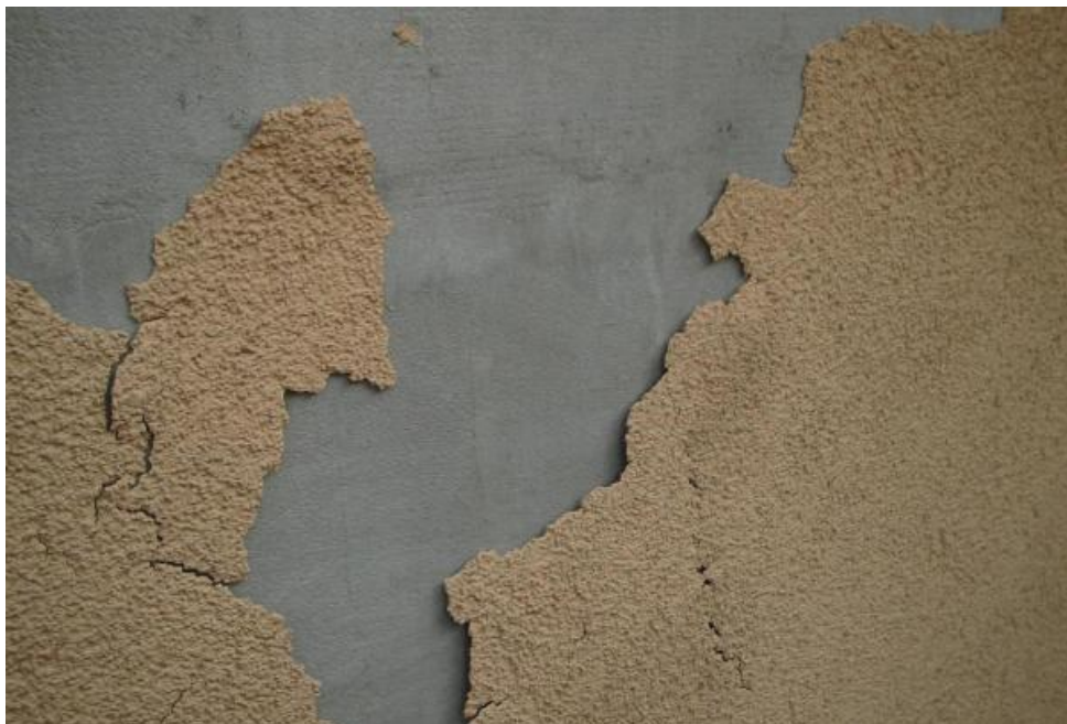
Рисунок 1.5 – Відшарування штукатурки «мокрого» фасаду
