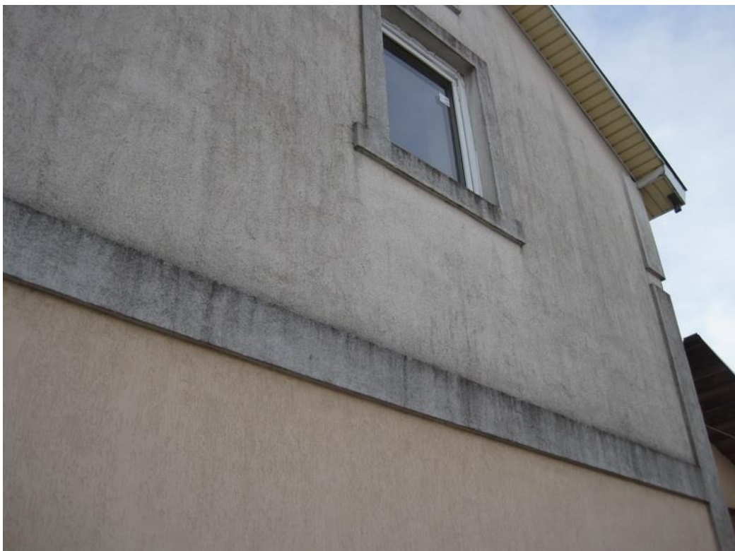
Рисунок 1.9 – Забруднення «мокрого» фасаду з рельєфною штукатуркою
