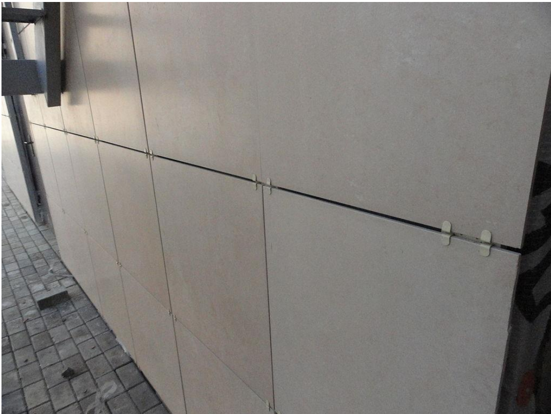
Рисунок 1.11 – Зазори між плитками вентилязованого фасаду
