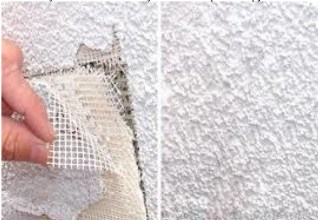
Рисунок 1.7 – Змінання утеплювача при відшаруванні
