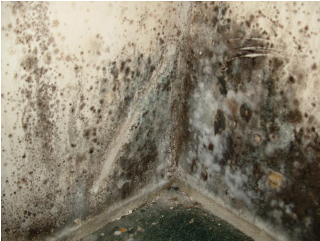
Рисунок 1.6 – Пліснява на поверхні штукатурки «мокрого» фасаду
