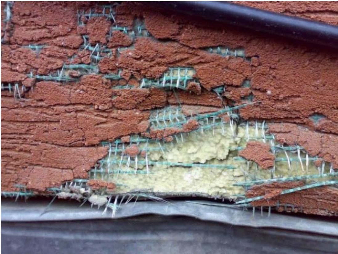
Рисунок 1.7 – Змінання утеплювача при відшаруванні
