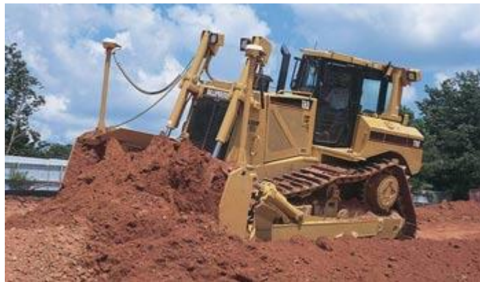
Рис. 2. Бульдозер, обладнаний приладами позиціонування при формуванні ухилу
