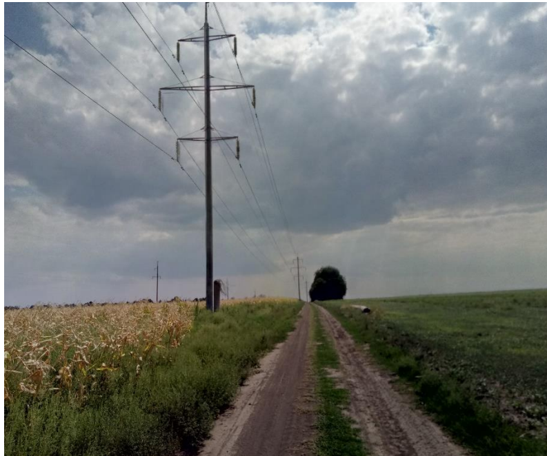
Рис.1.Обстеження та оцінка технічного стану залізобетонних центрифужованих стік висковольтних мереж
