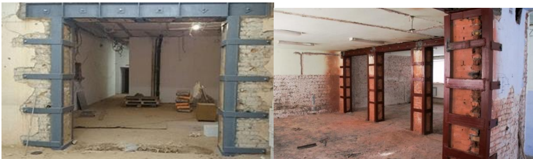
Рис.6. Розробка проектної документації на підсилення несучих конструкцій при виконанні в них отворів
