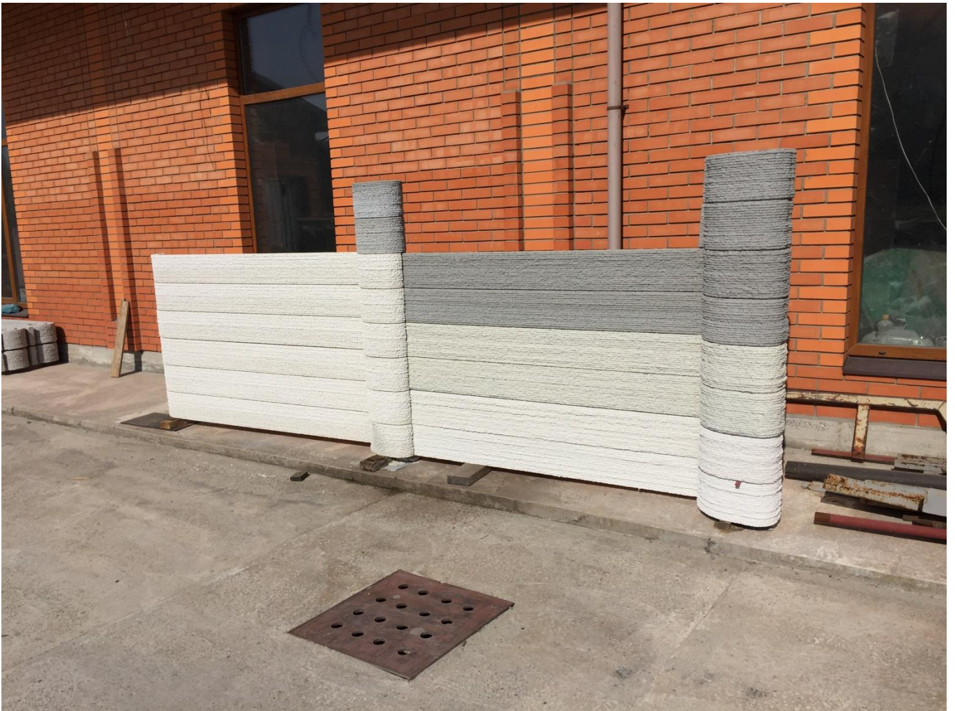
Рис. 16. Загальний вигляд секцій забору виготовлених на 3D принтері
