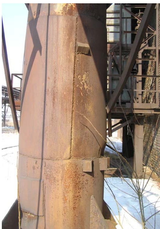
Рисунок 4.18 – Утрата стійкості стовбура димової труби
