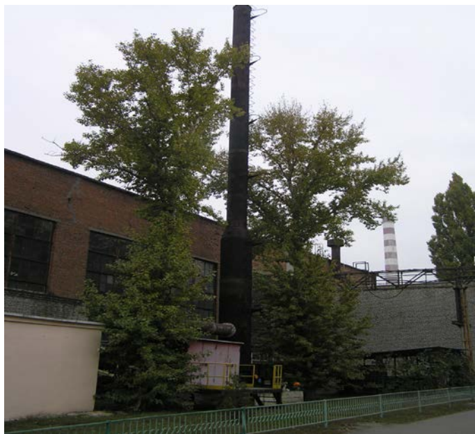
Рисунок Б.5 – Металева димова труба висотою 25.70 м термічних печей механічного цеху.
