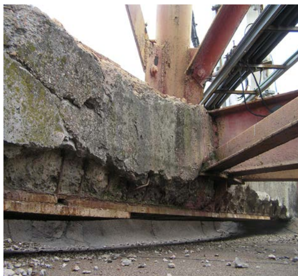
Рисунок 4.29 – Руйнування бетону фундаменту і бетонування опорної балки:
