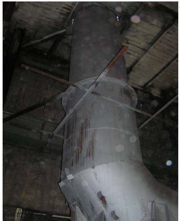
Рисунок .35 – Вигин димової труби при переході від горизонтального газоходу до вертикального стовбура
