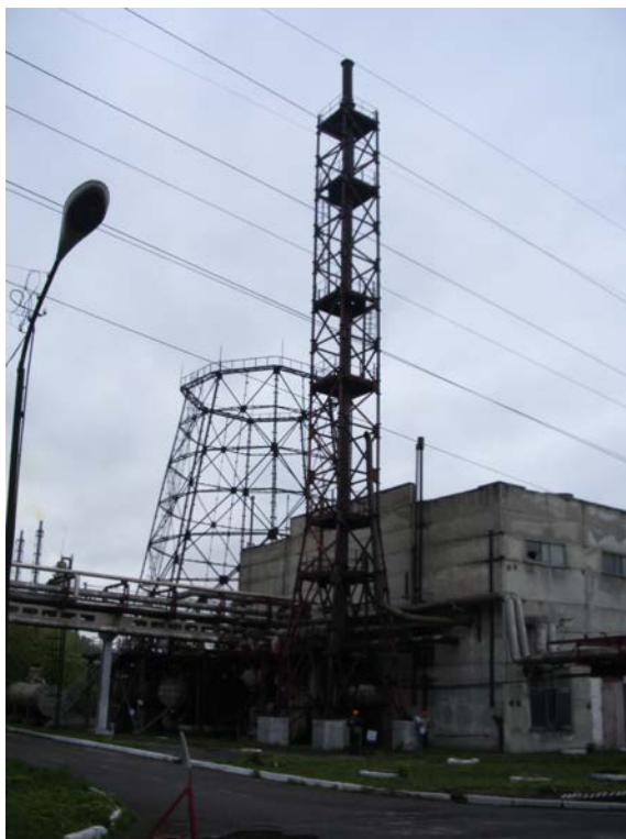
Рисунок Б.13 – Металева вежа висотою 35.00 м і димова труба висотою 39.00 м корпусу 876 ВАТ «Азот», м. Кемерово
