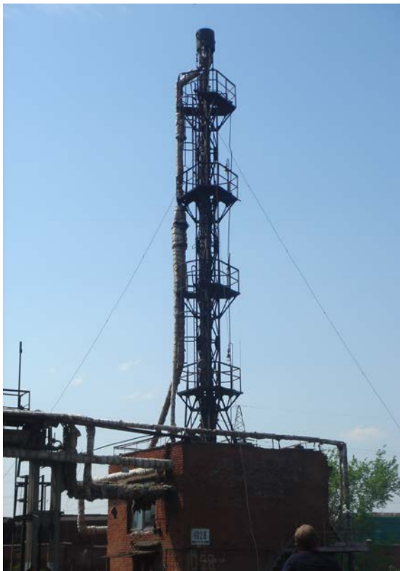
Рисунок 16 – Металева факельна труба і вежа висотою 30.00 м корпусу 1028 Кемеровського ВАТ «Азот»
