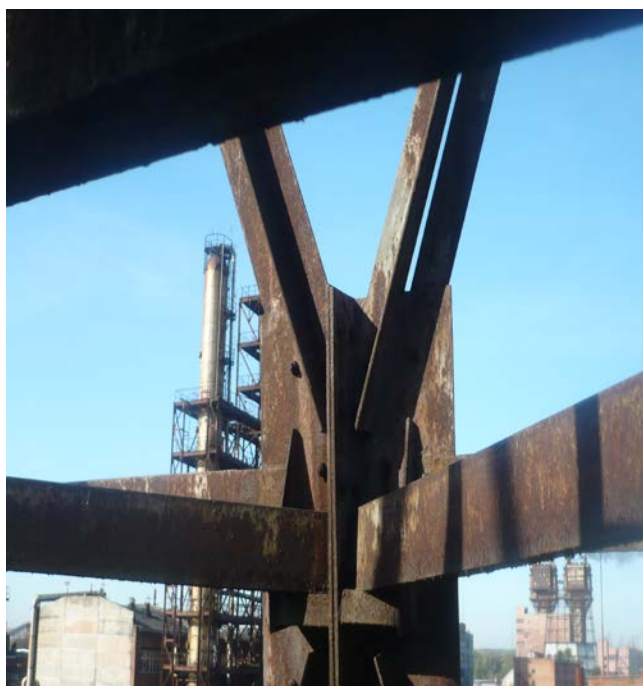
Рисунок 4.23 – Корозія елементів металевої вежі:
