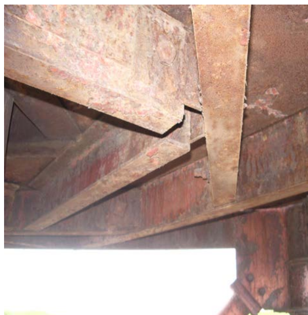
Рисунок 4.23 – Корозія елементів металевої вежі:
