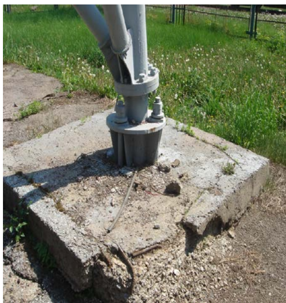
Рисунок 4.29 – Руйнування бетону фундаменту і бетонування опорної балки:
