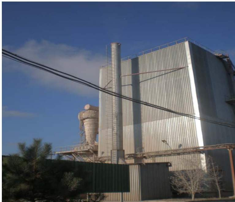
Рисунок Б.6 – Металева димова труба висотою 25.00 м газоочищення печі КС-55 мартенівського цеху
