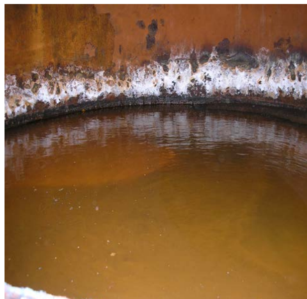
Рисунок 4.13 – Корозійний знос стінки стовбура димової труби:
