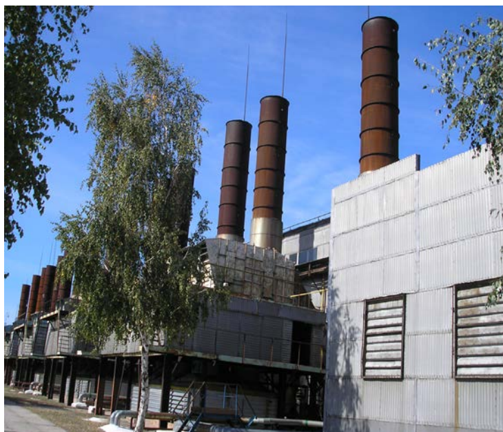
Рисунок Б.2 – Металеві димові труби КС «Кіровоградська»
