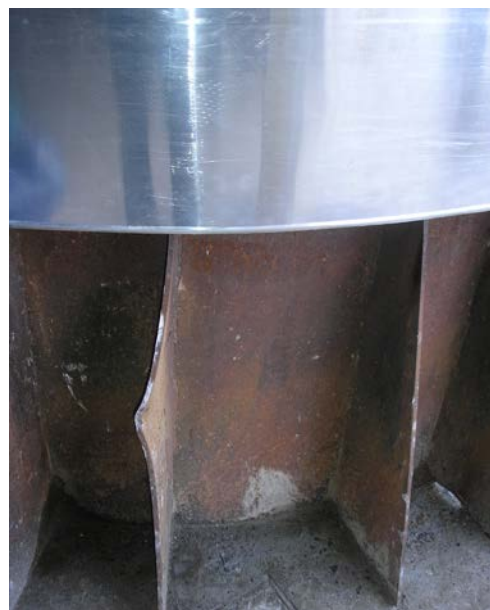
Рисунок 4.16 – Пошкодження ребер опорних вузлів труби:
