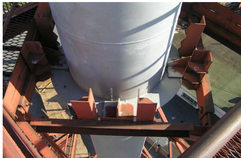
Рисунок 1.16 – Вузол передавання горизонтального навантаження за допомогою ковзних опор:
