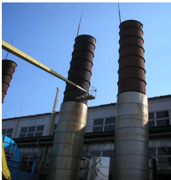
Рисунок 4.2 – Визначення товщини стовбурів димових труб:
