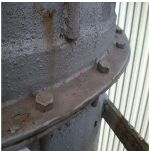
Рисунок 4.15 – Ослаблення або пошкодження болтових з'єднань:
