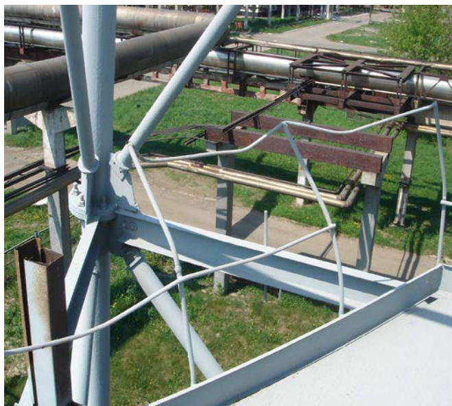
Рисунок 4.28 – Деформація елементів вежі:
