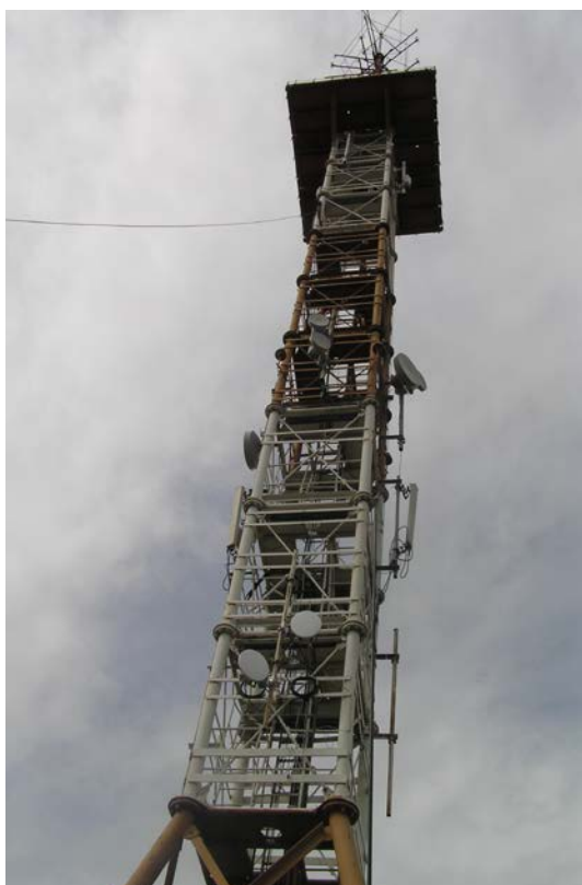
Рисунок Б.24 – Металева вежа висотою 32.50 м на даху будівлі Держпром у м. Харкові
