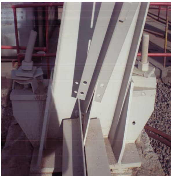
Рисунок 4.28 – Деформація елементів вежі:
