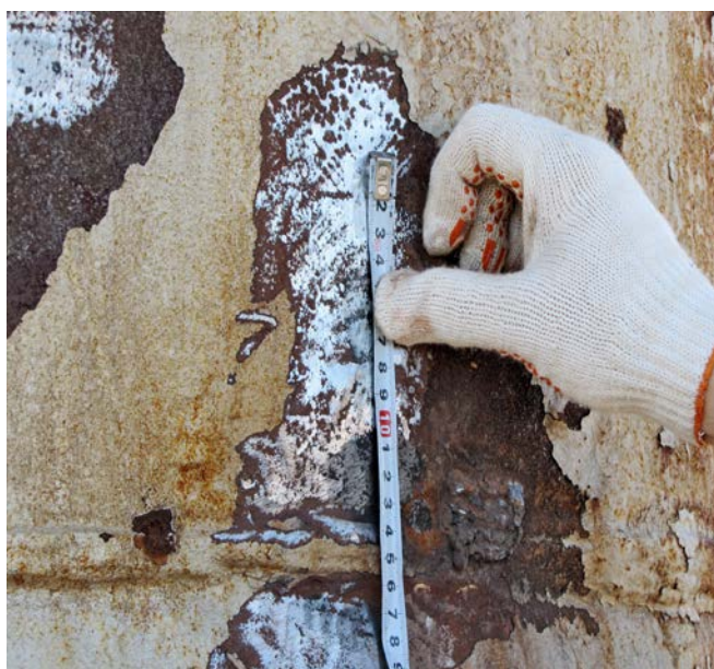
Рисунок 4.14 – Локальні або виразкові (враховуючи прогари) корозійні пошкодження стінки стовбура труби:
