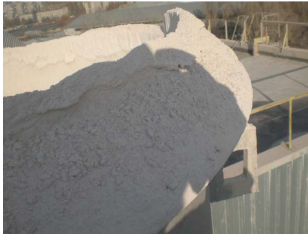
Рисунок 1.26 – Відкладення пилу на оголів'ї труби
