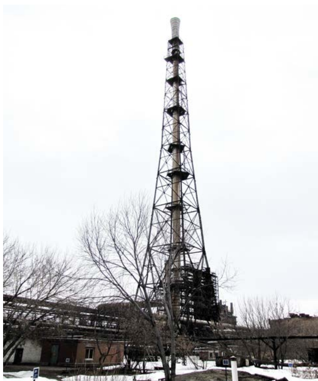
Рисунок Б.15 – Металева вентиляційна труба і вежа висотою 90.00 м
