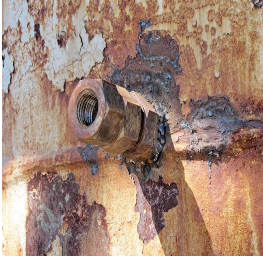
Рисунок 5.5 – Тимчасова заглушка на місці прогару у стовбурі димової труби
