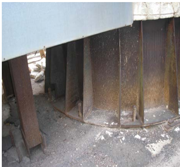
Рисунок 4.15 – Ослаблення або пошкодження болтових з'єднань:
