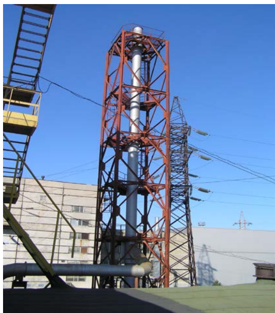
Рисунок Б.23 – Металева димова труба висотою 27.00 м і несуча вежа висотою 25.00 м скловарних печей ТСЦ-3.
