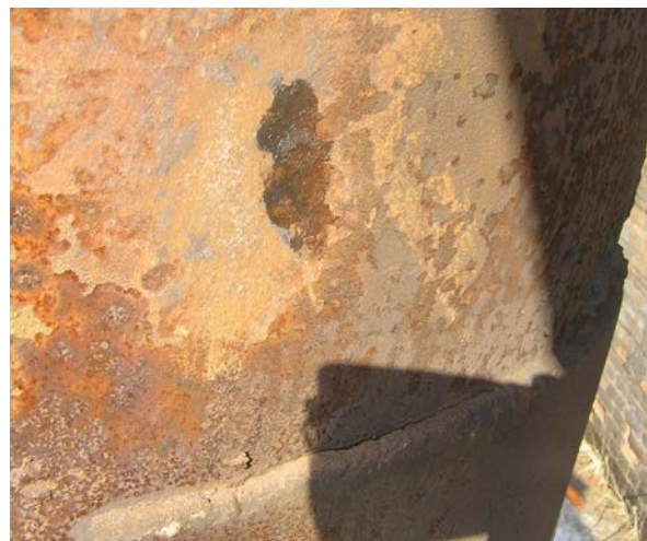
Рисунок 4.12 – Непровари і тріщини у зварних швах металевих димових труб:
