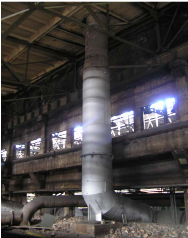
Рисунок .35 – Вигин димової труби при переході від горизонтального газоходу до вертикального стовбура
