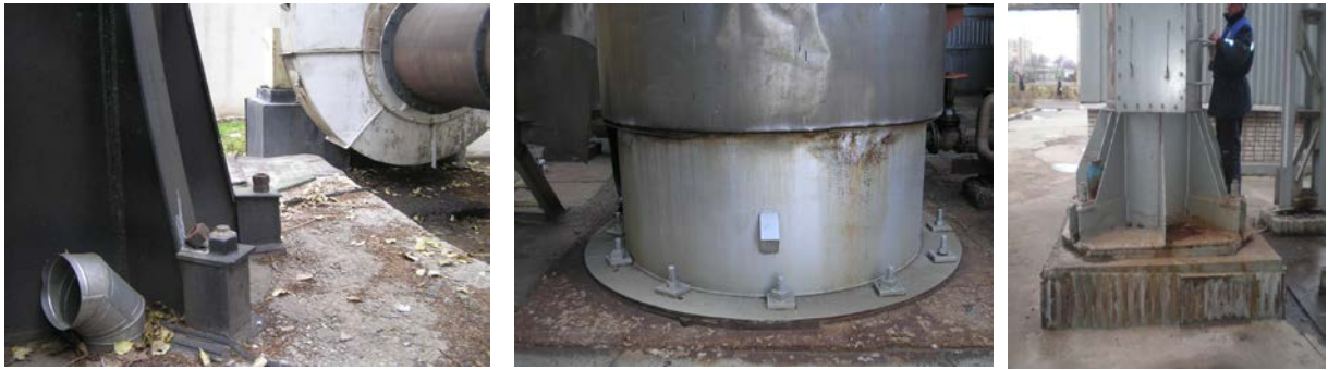
Рисунок 1.7 – Опорні вузли металевих димових труб:
