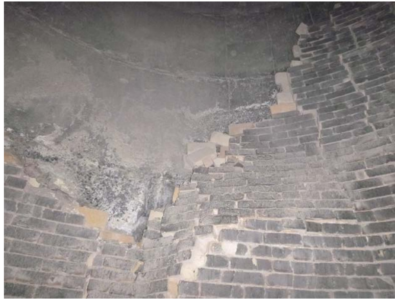
Рисунок 1.28 – Пошкодження футеровки стовбура після вибуху горячої суміші у трубі («хлопка»)
