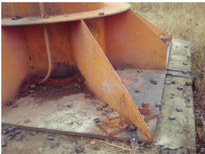
Рисунок 4.12 – Непровари і тріщини у зварних швах металевих димових труб:
