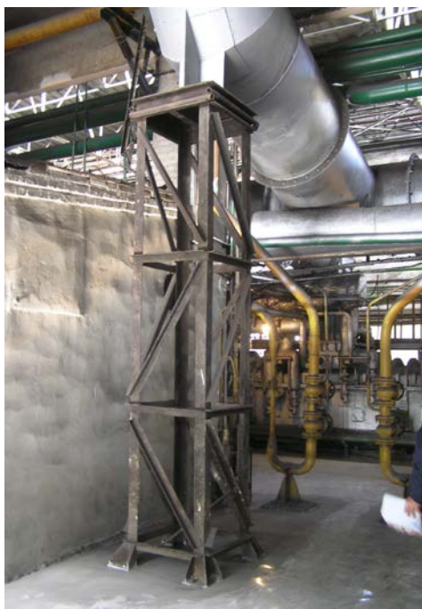
Рисунок 4.17 – Елементи решітки металевої опори під димову трубу вирізані
