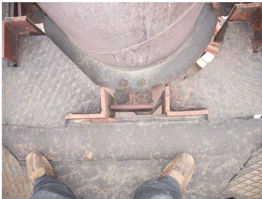
Рисунок 4.26 – Понаднормовий проміжок між елементом діафрагми і ковзним упором труби
