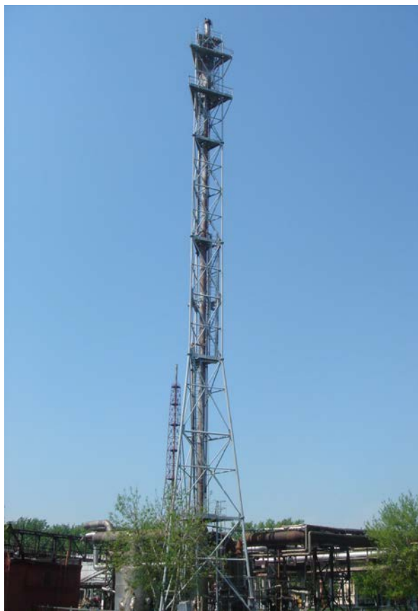
Рисунок Б.18 – Металева факельна труба висотою 60.00 м і вежа висотою 57.40 м цеху 2004 a Кемеровського ВАТ «Азот»
