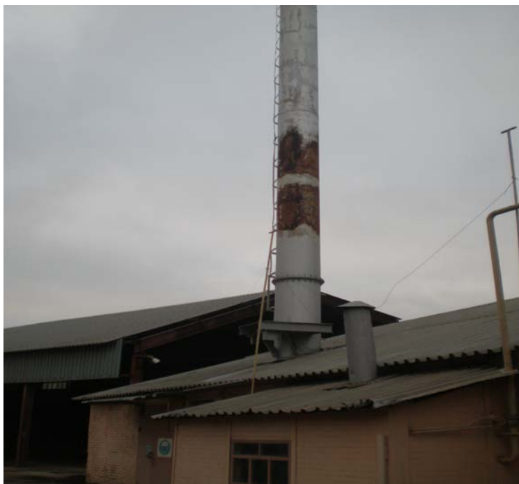
Рисунок Б.7 – Металева димова труба висотою 17.8 м печі обпалу мартенівського цеху
