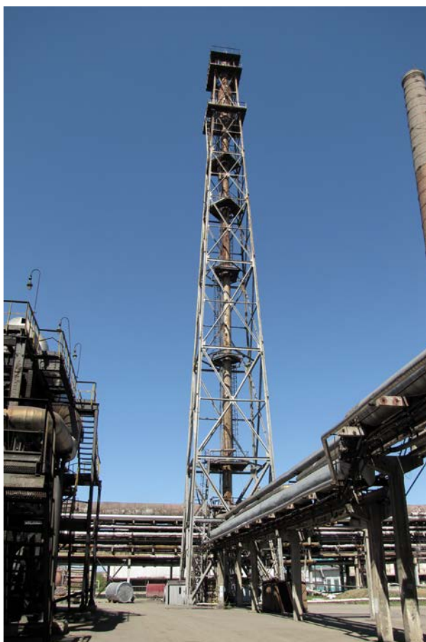
Рисунок Б.14 – Металева димова труба і вежа висотою 78.00 м факельної установки корпусу 650 Кемеровського ВАТ «Азот»
