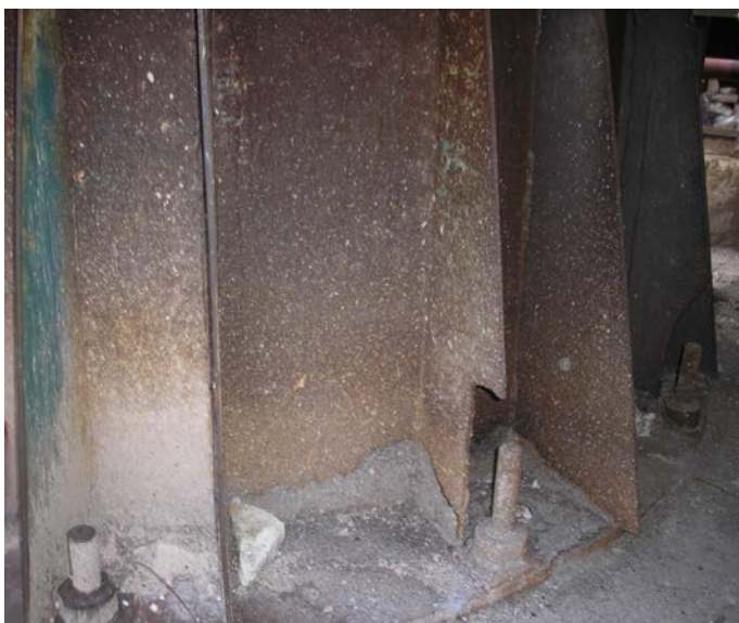
Рисунок 4.16 – Пошкодження ребер опорних вузлів труби:
