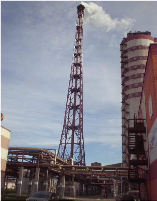
Рисунок 1 – Металева витяжна труба і несуча вежа цеху «Аміак 4»
