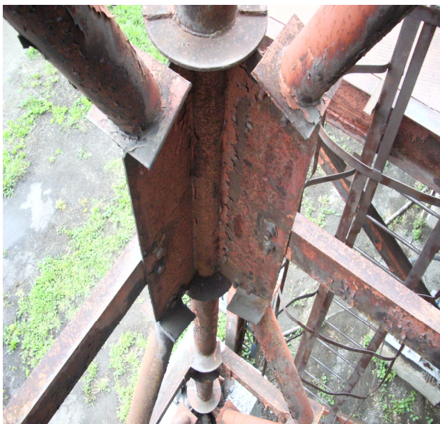
Рисунок 19 – Корозійний знос елементів вежі, що перевищує 10% площі перерізу
