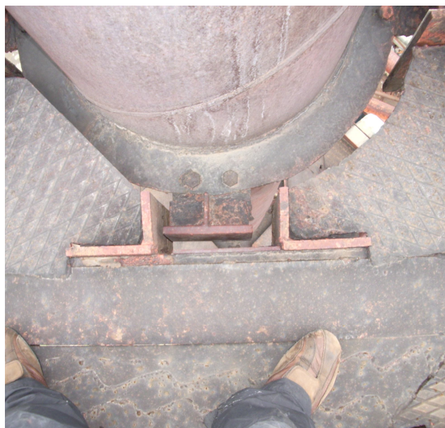
Рисунок 20 – Пошкодження упорів кріплення з площини димової труби
