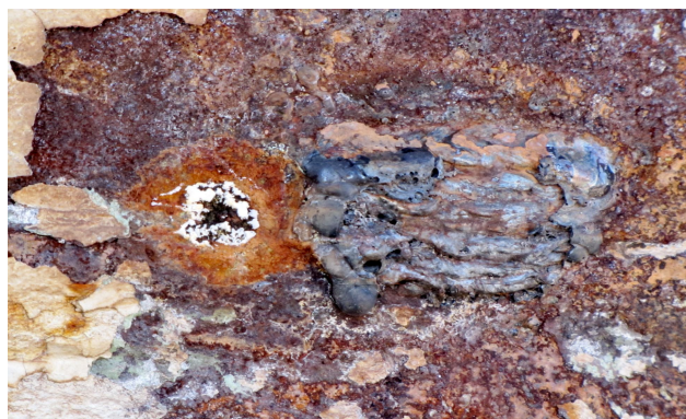
Рисунок 12 – Локальне наскрізне корозійні пошкодження стінки труби
