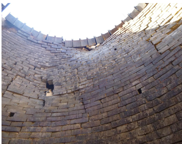
Рисунок 16 – Випинання кладки футеровки
