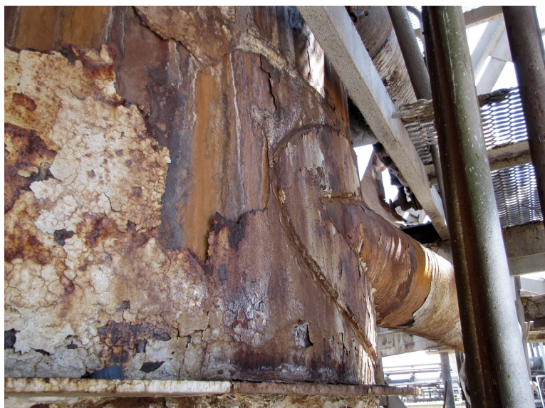
Рисунок 8 – Корозія ствола димової труби понад 10%
