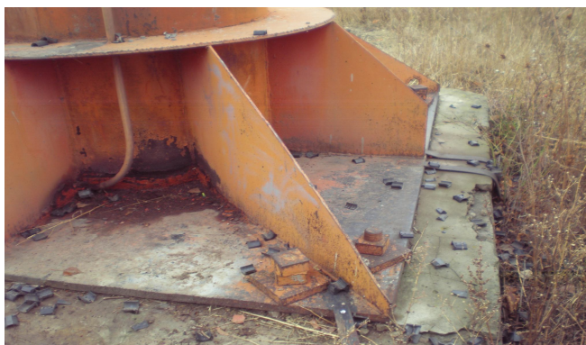
Рисунок 11 – Тріщини у кутиковому зварному шві приварки ребер до плити
