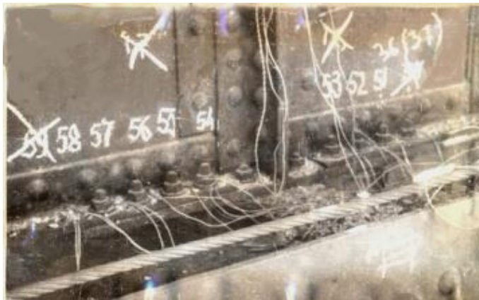
Рисунок 3.1 – Загальний вид установки тензорезисторів на поздовжній лівій балці Б1 в сполученні з поперечною балкою П2
