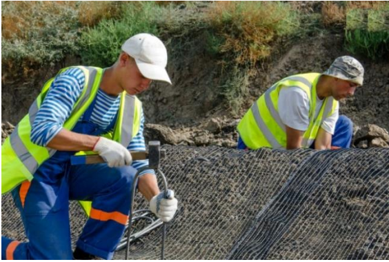
Рис. 4.3. Студенти виконують арматурні роботи в період практики на будівництві житлового комплексу
