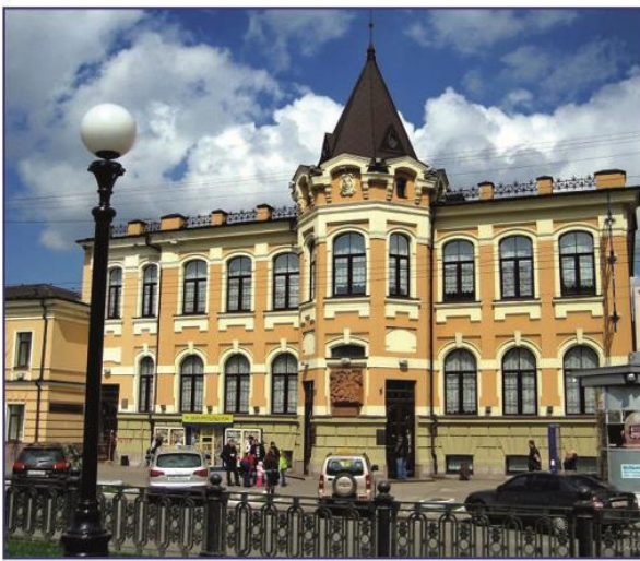
Реконструкція пам'ятки архітектури, будівлі Головоштамту, 2003 р. (Л. Г. Попов, В. В. Житніков)
