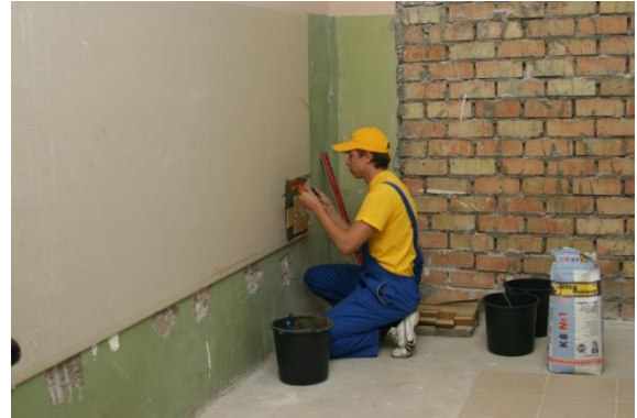
Рис. 4.4. Роботи на будівельних об'єктах студентів факультету ПЦБ у період виробничої практики по кафедрі технології будівельного виробництва
