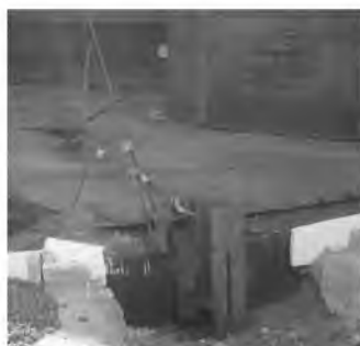
Фото 4. Разворачивание рулона с использованием однорольного блока и монтажной скобы
