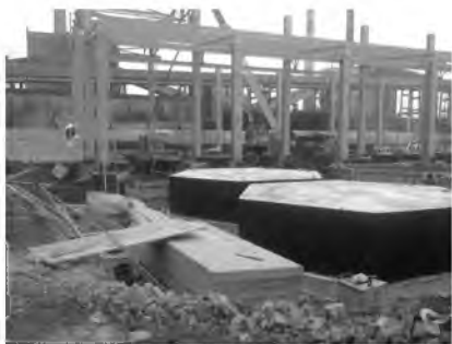
Фото 3. Возведение вертикальных стальных резервуаров в стесненных условиях
