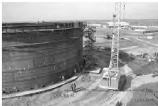
Фото 1. Строительная площадка при возведении стального цилиндрического резервуара
