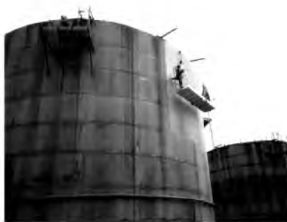
Фото 6. Выполнение окрасочных работ с люльки
