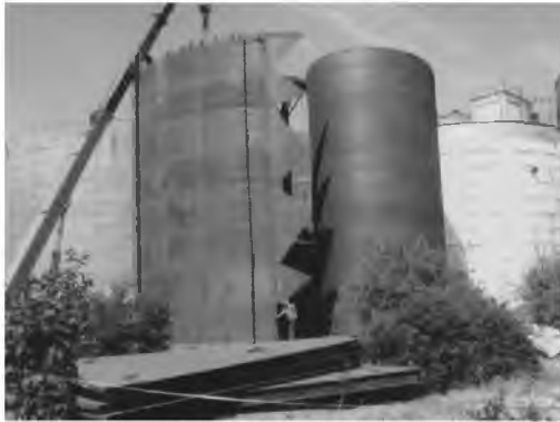
Фото 2. Возведение резервуара методом рулонирования
