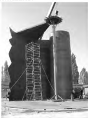
Фото 5. Выполнение сварочных работ с инвентарных передвижных подмостей
