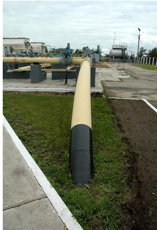
Fig. 5. Pipelines at the ammonia pumping station ( https://ru.wikipedia.org/wiki/Аммиакопровод )
